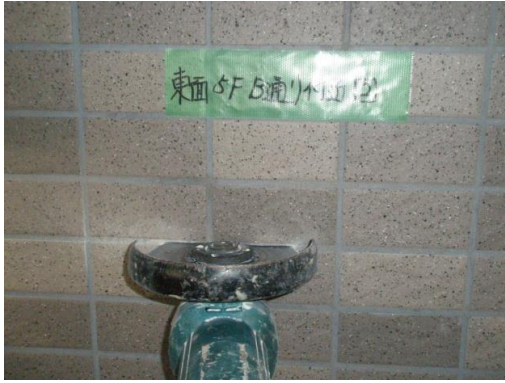
（写真はタイル目地切断 50二丁）
