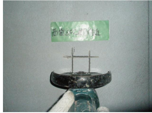
（写真は下地モルタル切り込み 40×40mm）
