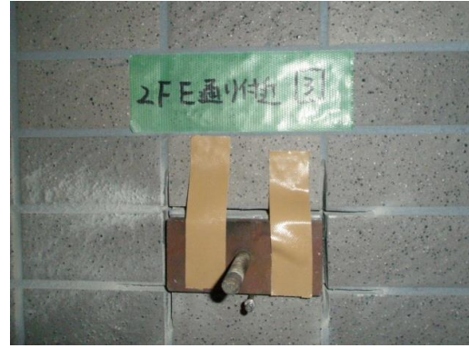
(鋼製アタッチメント貼付け・養生)
